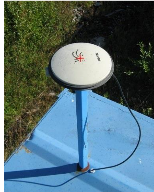
Bild 1. Basstationens inspektionsmätning görs med totalstation på antennens mittpunkt.
